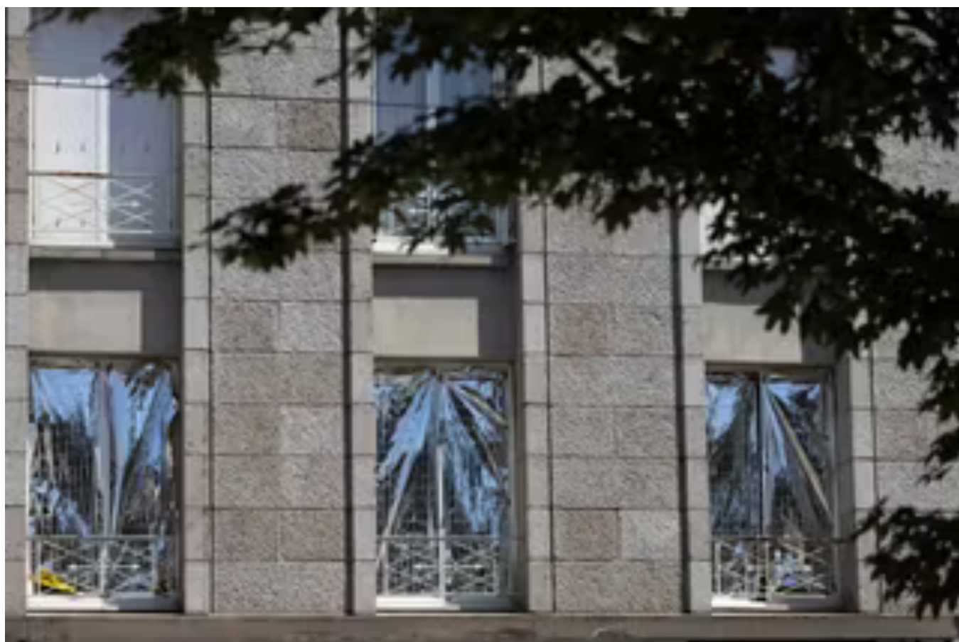
Des couvertures de survie aux fenêtres d'un immeuble à Brest (Finistère), le 7 juillet 2025. FRED TANNEAU/AFP
